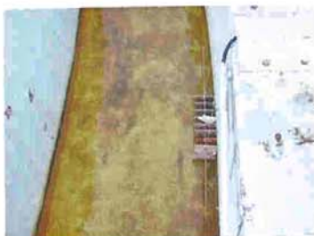
Figuur 1 Ingebouwde probes bezinkingsbekkens waterzuiveringsinstallatie
